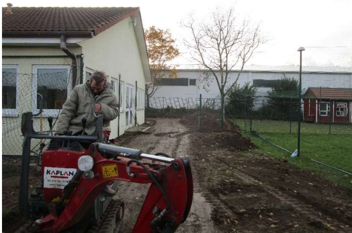
Abbildung 1: Die ersten Vorbereitungen für den Bau der neuen Besuchersanitäranlage haben begonnen.
